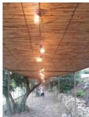
Et bien non, le paillasson n'est pas en Camargue l'objet sur lequel on s'essuie les pieds! Souvent utilisé dans les mas de Provence et de Camargue, le **paillasson** est en fait un rouleau de roseaux tressés et cousus entre eux au point de chaînette, avec un fil de nylon, dans différentes largeurs, pour donner les fameux paillassons qui procure une ombre rafraîchissante et efficace ; ils furent longtemps confondu avec leur cousin: le **canisse provençal**.
