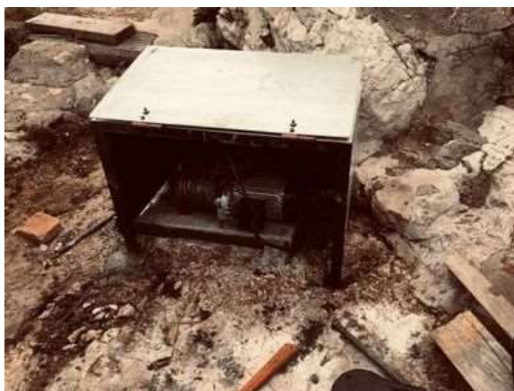
Un treuil en place qui va bien faciliter la remontée du bateau
